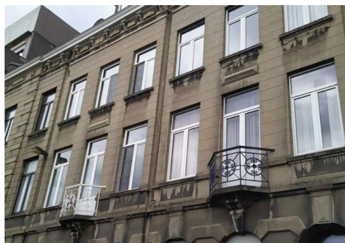
Fig. 2.7 Enduits extérieurs à base de chaux (à gauche) et de ciment (à droite).
