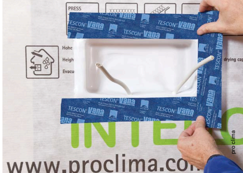
Fig. 6.34 Solutions possibles pour rendre les raccords des câbles étanches à l'air.
