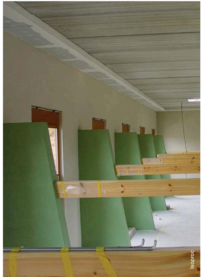
Fig. 6.23 Retour d'isolant au niveau du plafond.
