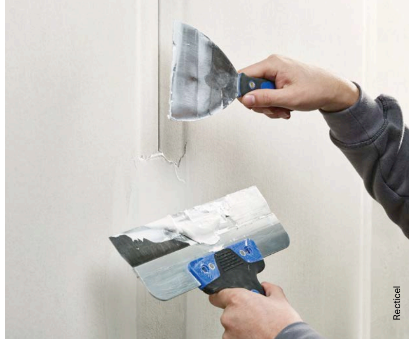
Fig. 6.11 Réalisation des joints entre panneaux préfabriqués.
