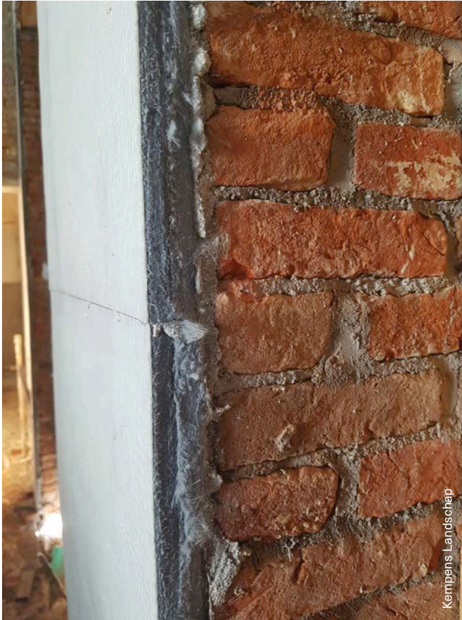
Fig. 4.2 Avec une valeur \lambda de 0,014 W/m·K, l'aérogel isole deux à trois fois mieux que la plupart des isolants conventionnels, mais coûte généralement plus cher.
