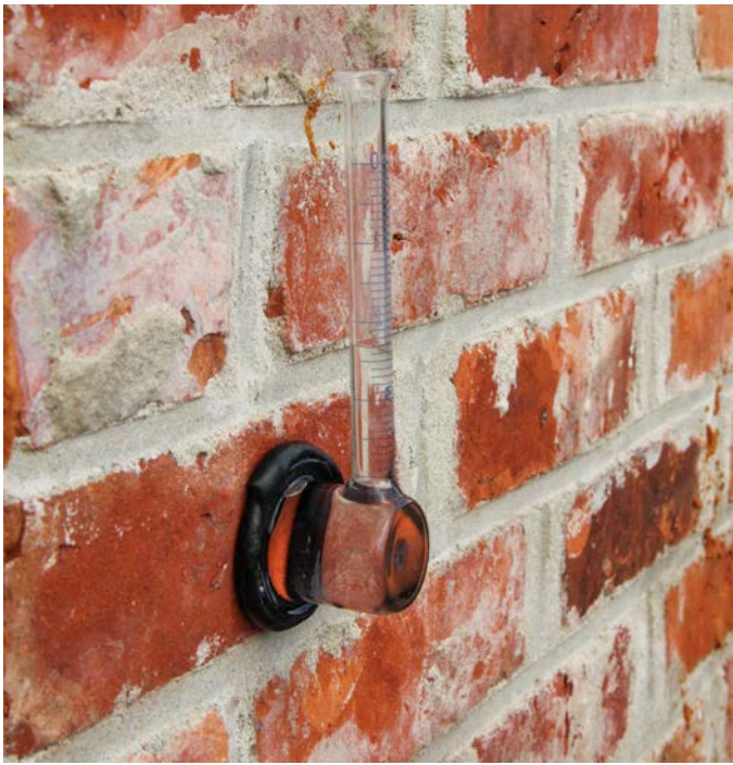
Fig. 3.11 Mesure d'absorption d'eau à la pipe de Karsten.
