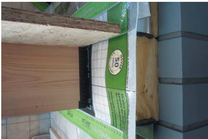
Fig. 6.27 Démonstration d'un raccord étanche à l'air autour des solives : raccord entre une solive et une membrane à l'aide d'un ruban adhésif (à gauche) et raccord entre une solive et un panneau au moyen d'une mousse PU élastique (à droite).
