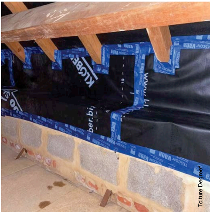
Fig. 6.31 Barrière d'étanchéité à l'air de l'isolation de la toiture, parachevée de façon étanche à l'air au niveau des chevrons et prête pour un raccord à un système d'isolation par l'intérieur.
