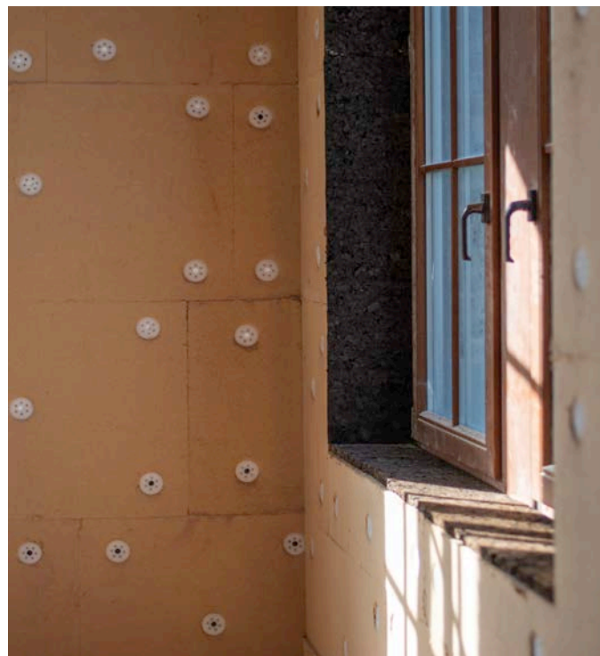
Fig. 6.18 Isolation des embrasures de fenêtres avec du liège.
