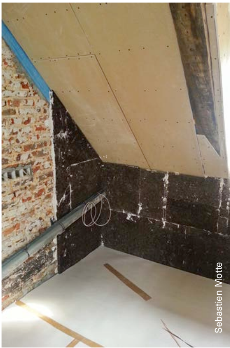
Fig. 6.21 Raccord de l'isolation par l'intérieur à un mur intérieur au moyen d'un retour d'isolant droit ou biseauté (photo et schéma à gauche) ou par le remplacement du mur par une paroi de séparation légère (schéma à droite).
