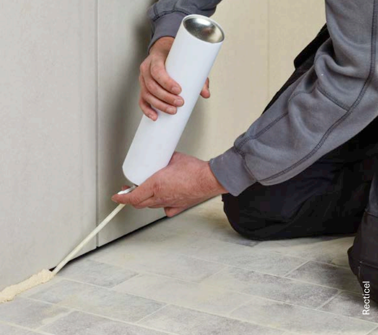
Fig. 6.10 Injection de mousse le long des bords.
