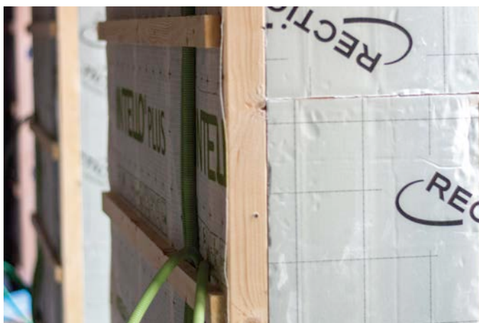
Fig. 6.32 Gaine technique permettant d'installer les conduites sans percer la barrière d'étanchéité à l'air.
