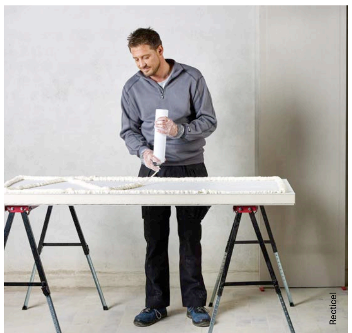
Fig. 3.15 Collage en plein (à gauche) et collage sous forme de bandes à l'aide de mousse PU, accompagné d'un collage continu sur les bords du panneau (à droite).
