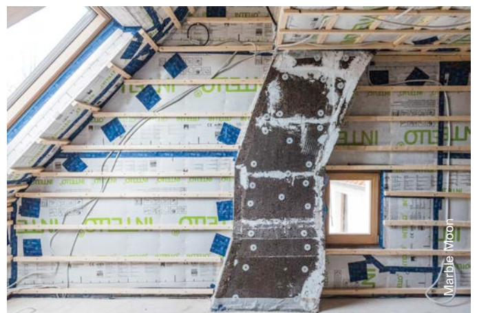
Fig. 6.32 Gaine technique permettant d'installer les conduites sans percer la barrière d'étanchéité à l'air.
