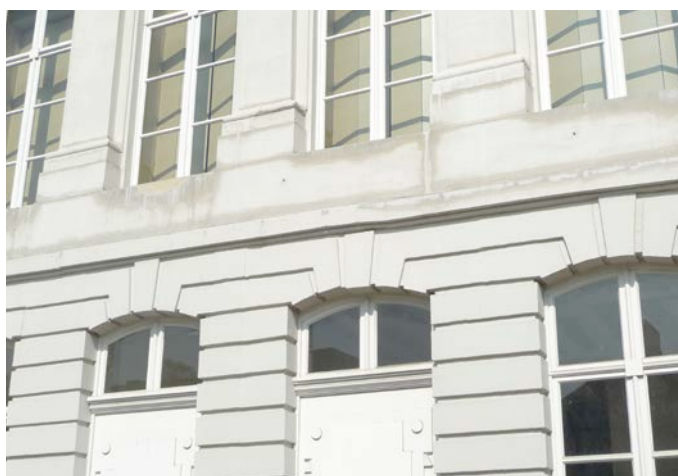
Fig. 2.7 Enduits extérieurs à base de chaux (à gauche) et de ciment (à droite).
