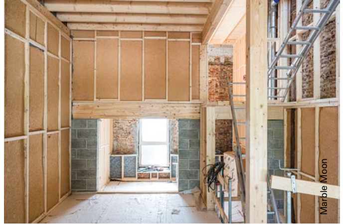
Fig. 1.3 Comme l'isolation par l'intérieur implique souvent des interventions importantes, elle peut être associée à d'autres travaux de rénovation.
