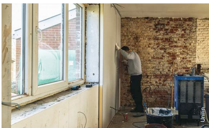
Fig. 3.7 Panneaux grand format en polyisocyanurate (PIR) déjà équipés d'un panneau de finition.
