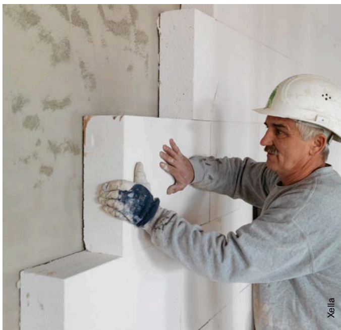
Fig. 3.6 Collage au mur de blocs isolants en béton cellulaire ultraléger.
