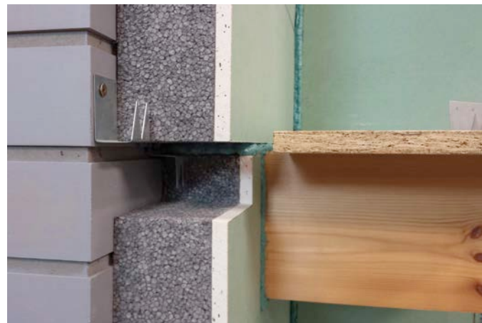
Fig. 6.27 Démonstration d'un raccord étanche à l'air autour des solives : raccord entre une solive et une membrane à l'aide d'un ruban adhésif (à gauche) et raccord entre une solive et un panneau au moyen d'une mousse PU élastique (à droite).
