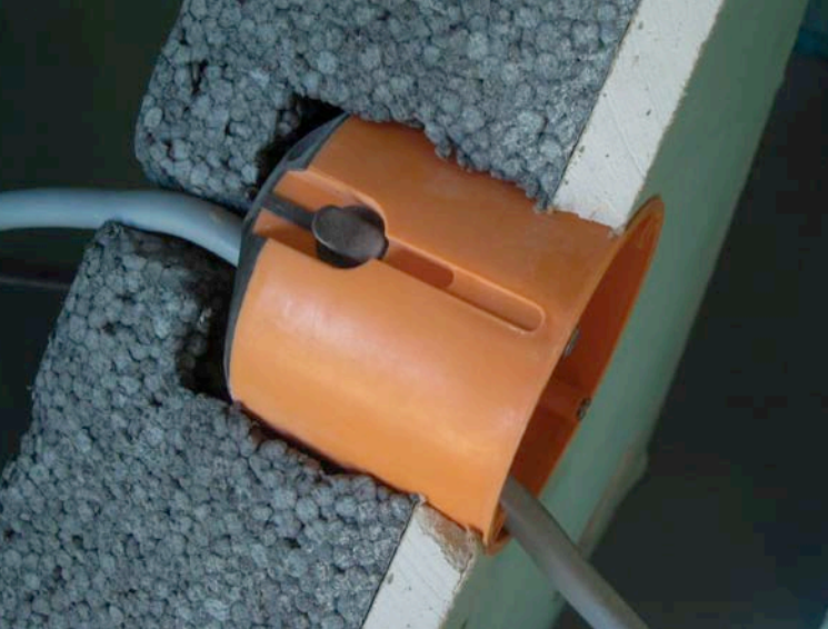
Fig. 6.34 Solutions possibles pour rendre les raccords des câbles étanches à l'air.
