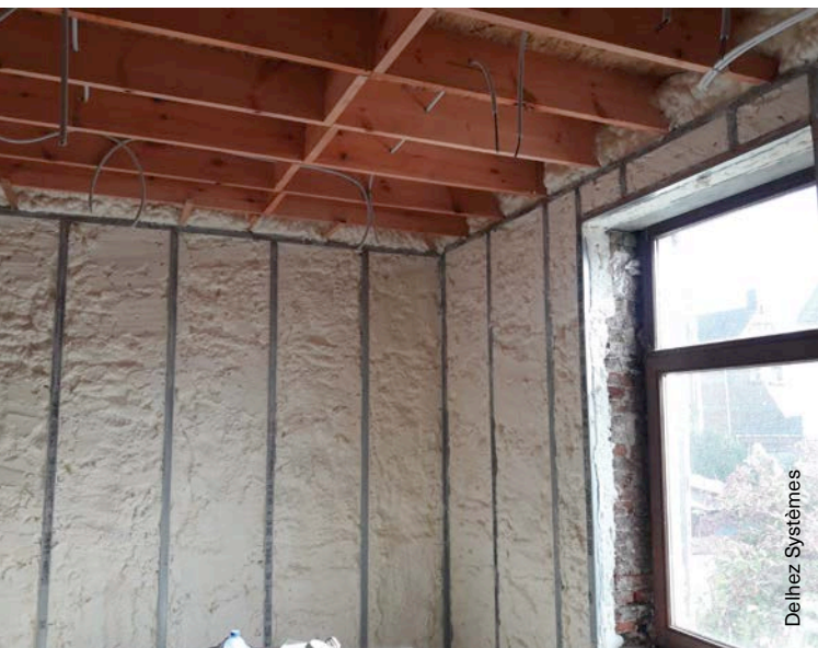
Fig. 3.4 Isolant projeté entre les éléments de l'ossature.
