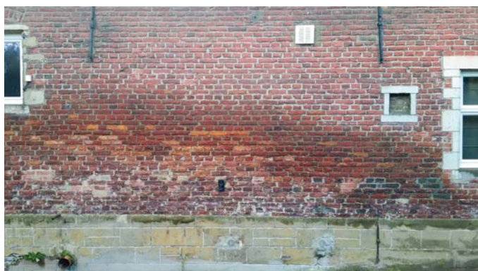
Fig. A.2 Taches d'humidité dues aux sels hygroscopiques (à gauche), altération par pulvérisation d'un joint de mortier en raison d'une cristallisation fréquente de sels efflorescents (à droite).
