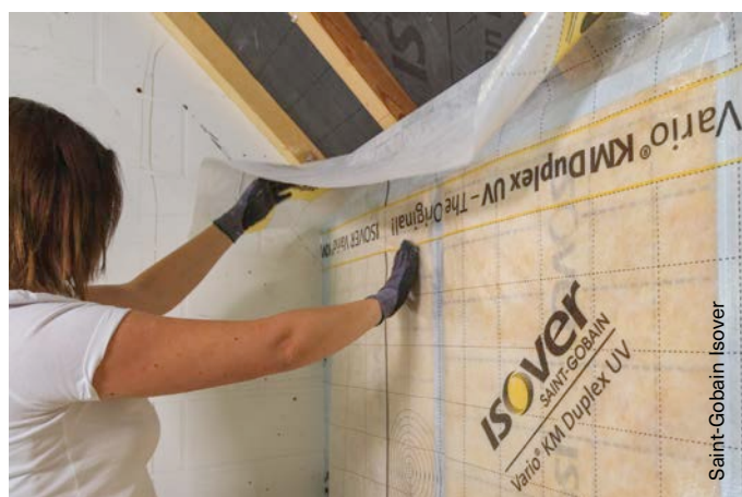
Fig. 3.18 Pose du pare-vapeur.
