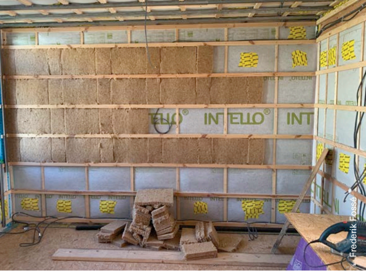
Fig. 3.2 Isolation du vide technique.
