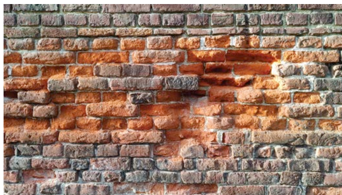
Fig. A.2 Taches d'humidité dues aux sels hygroscopiques (à gauche), altération par pulvérisation d'un joint de mortier en raison d'une cristallisation fréquente de sels efflorescents (à droite).
