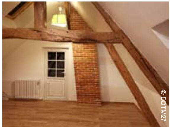
Aménagement de combles
